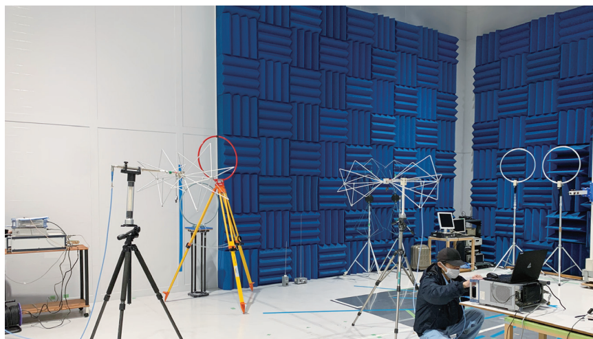
電磁波事業を拡大するために、南那須研究所に建設された同社の電波暗室
